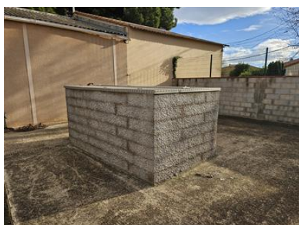
Forage F2 réservoir
